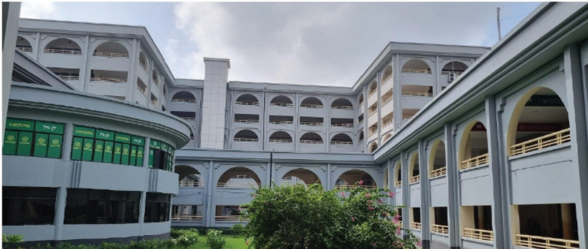
আশকোনাস্থ হজক্যাম্পের ডরমেটরির সংস্কার, রিংরোড নির্মাণ, উর্ধ্বমুখী সম্প্রসারণ
